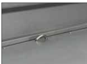
6 starke Zurrösen im Stahlboden eingelassen
